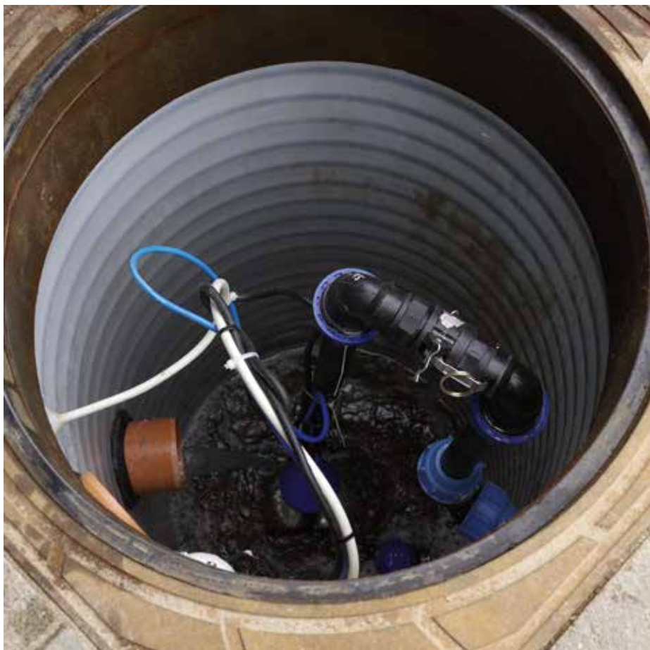
Der er mange løsninger på markedet for at undgå konsekvenserne af de værste oversvømmelser. Her en løsning med drænpumpe fra Grundfos.
