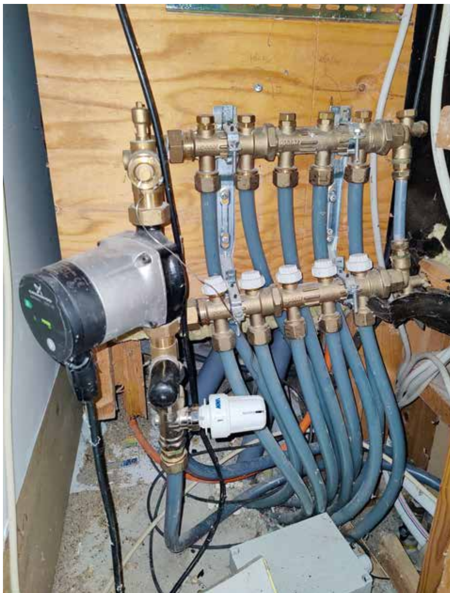
Ubalancen kan i visse driftssituationer føre til fænomener, hvor systemet bliver så ustabil, at beboere i enkelte lejligheder oplever manglende varme, fordi overliggende eller omkringliggende enheder reelt trækker alt flowet til sig.
