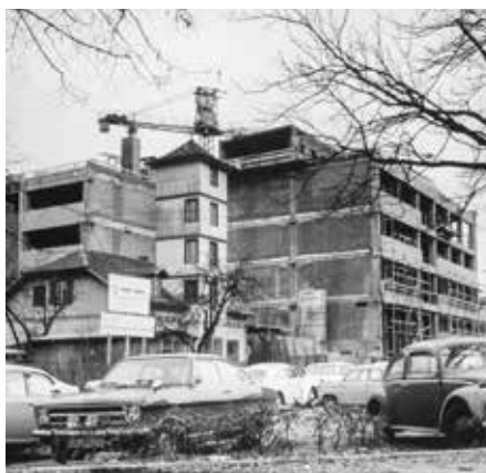
1960: Første fase af udvidelsen af hovedbygningen på Aue-værket i Schiltach.
